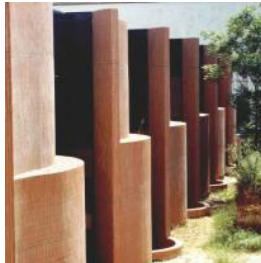
Edifici Coderch, de José Antonio Coderch de Sentmenat inaugurat el 1985
