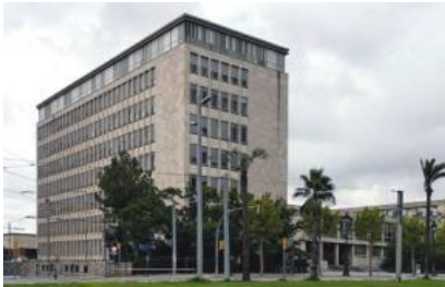
Edifici Segarra, projectat per l'arquitecte Josep Maria Segarra Solsona- 1961
