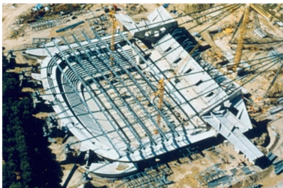
*Vista de la estructura principal de cubierta previa a la disposición del cerramiento*
