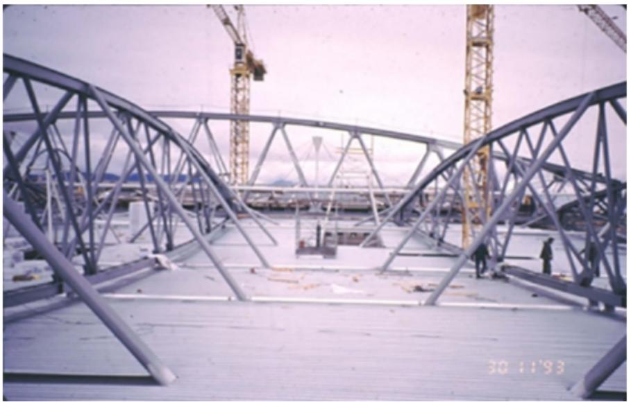
*Imagen de la cubierta definitiva en fase avanzada de construcción*
