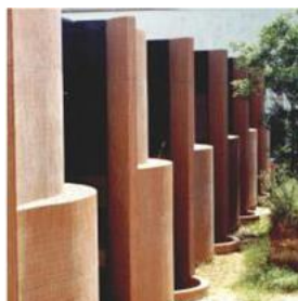
Edifici Coderch, 8.700 m 2
